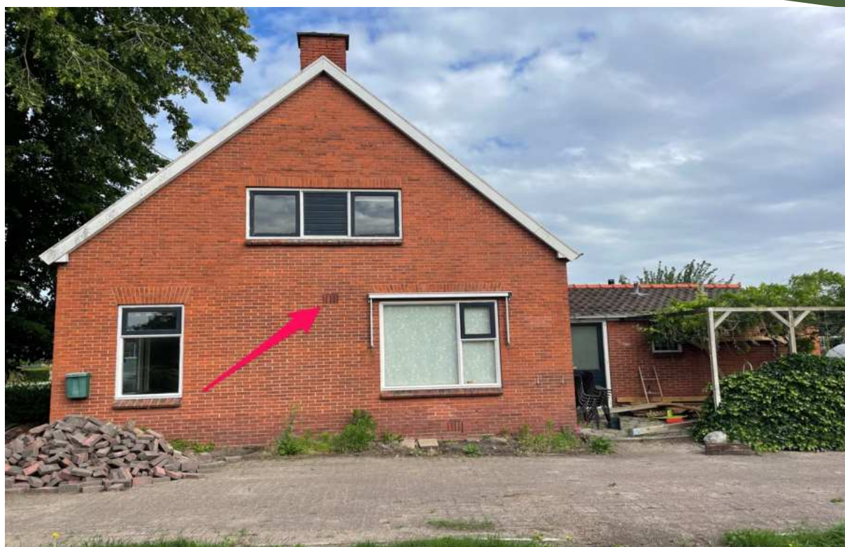
Figuur 11: Zijgevel met spouwmuur ventilatie zuidzijde
