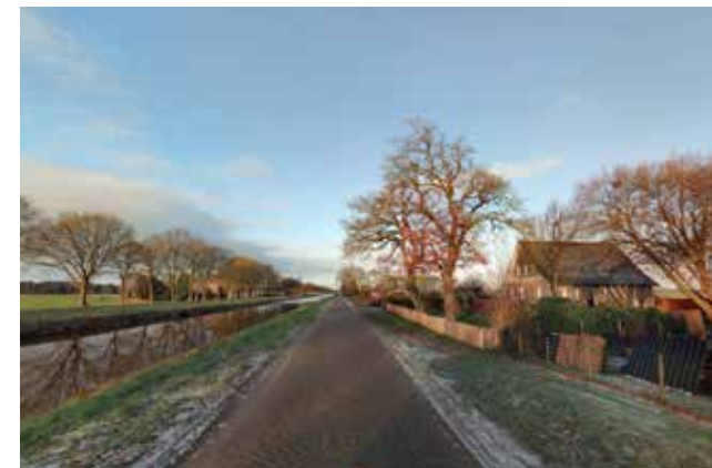
Afbeelding 17. Woonbebouwing aan Trekkenweg
