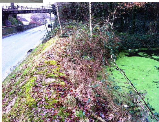
Foto 2: de dijk bij het Oranjekanaal ter hoogte van woonwijk de Rietlanden
