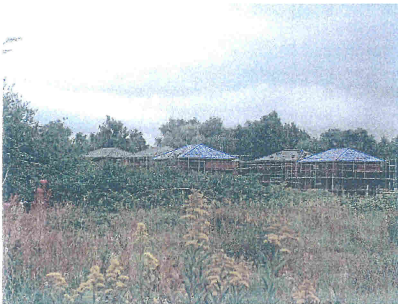
figuur 4. Woningen in aanbouw Laan van het Kwekebos
