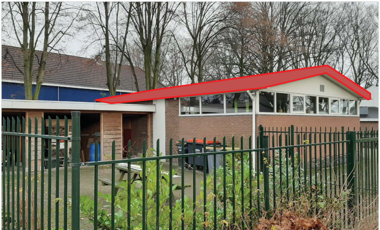
Afbeelding 7.1: dak zaal 1 (rood kader)
