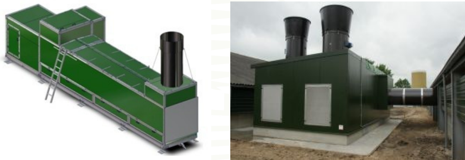
Foto 3 & 4: warmtewisselaar (situatie Buijs: 1 emissiepunt per wisselaar)
