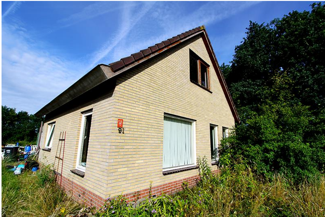
Planlocatie, te slopen woonhuis
