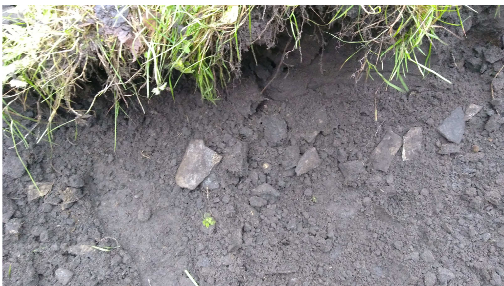
Foto 2. asbestverdacht materiaal tijdens ontgraven G8
