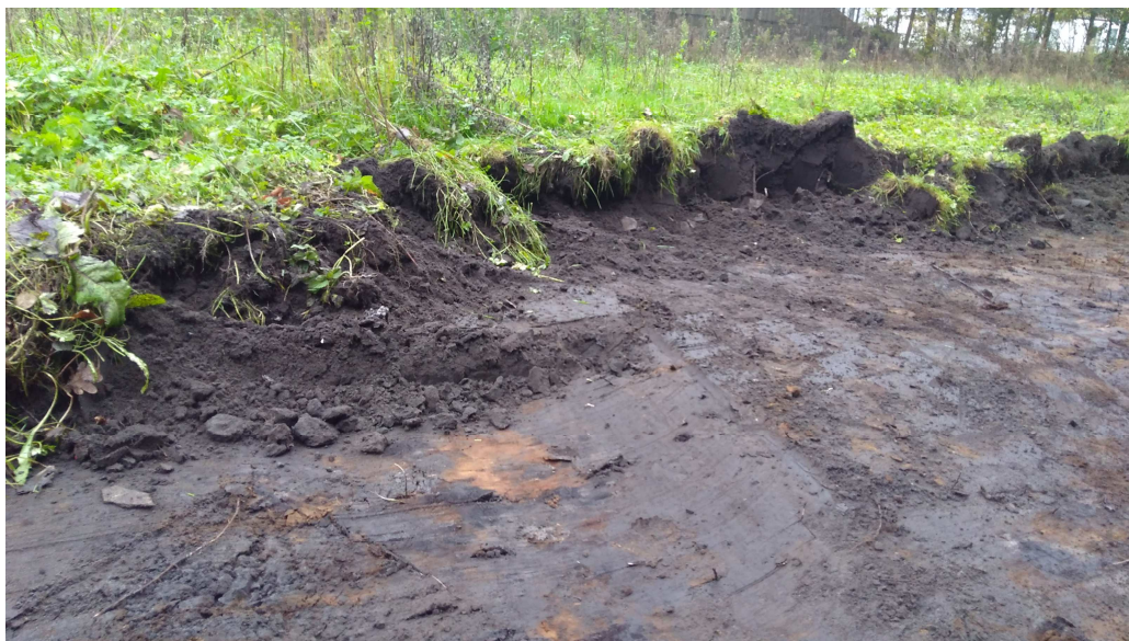
Foto 3. asbestverdacht materiaal tijdens ontgraven G8
