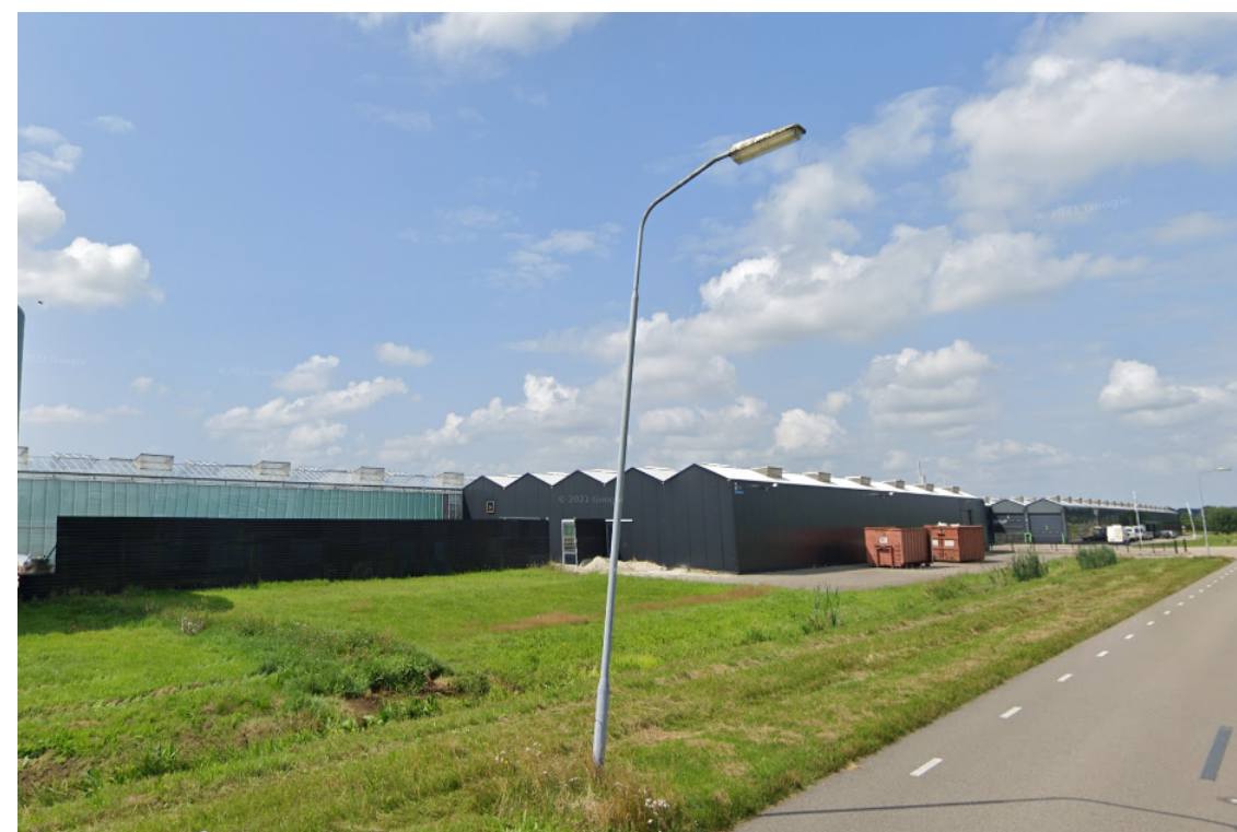
Afbeelding 4. Aanzicht noordzijde (bedrijfsvoering)
