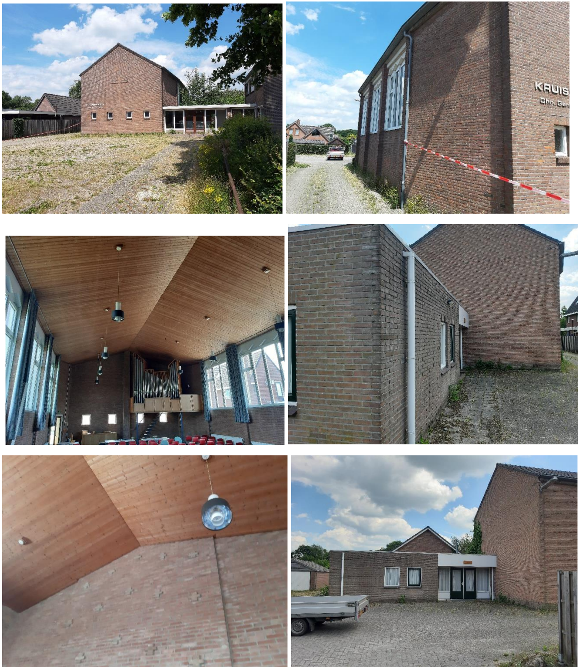
Figuur 2. Foto's bestaande situatie
