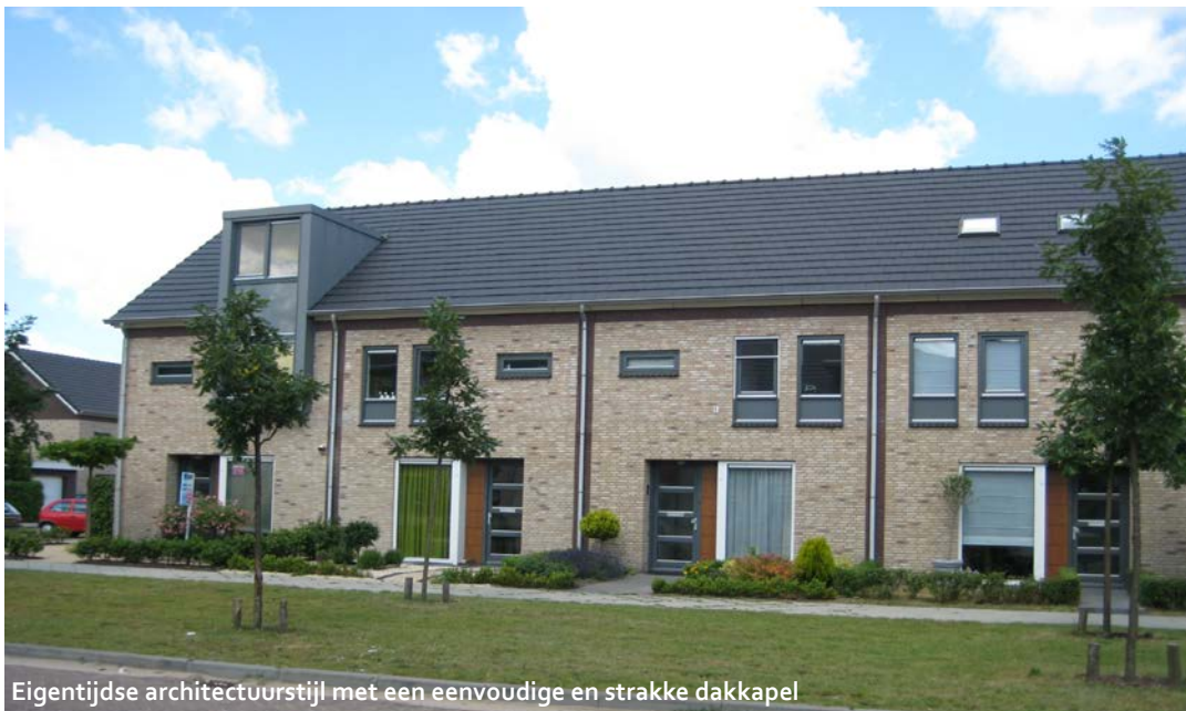
Vlakke en geordende gevels
