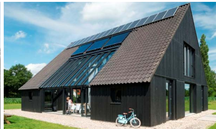
Rieten kap met zonnepanelen
