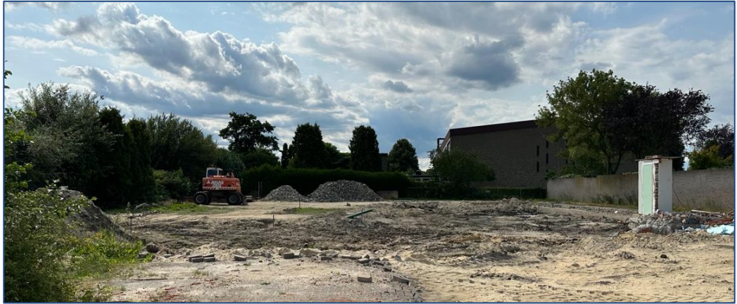
Fig. 4.2: Een weergave van het plangebied waar de voormalige bebouwing is gesloopt (foto d.d. 18 juli 2023).
