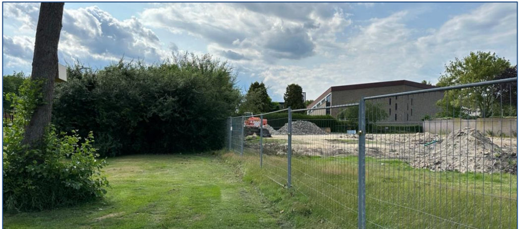
Fig. 4.3: Een weergave van het plangebied (binnen de begrenzing van de hekwerken) waar de voormalige bebouwing is gesloopt (foto d.d. 18 juli 2023).
