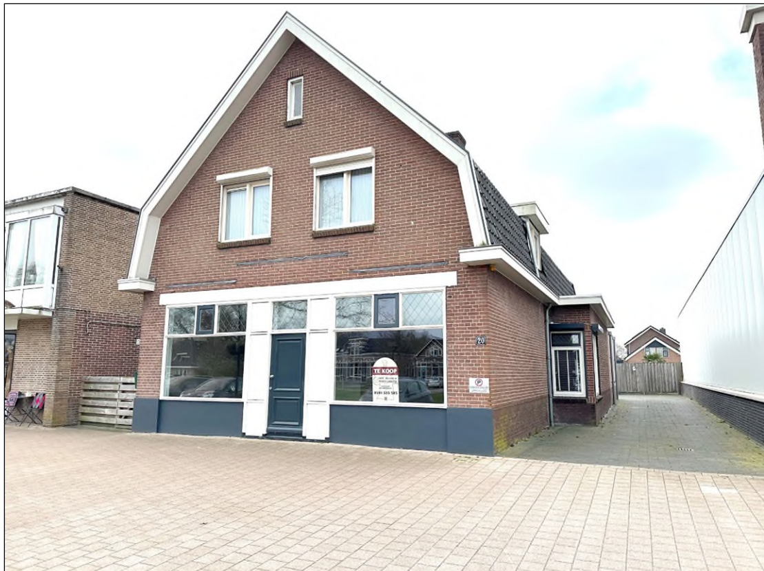
Figuur 3.1 Aanzicht voorgevel pand Zuidzijde 20 in Nieuw-Amsterdam
