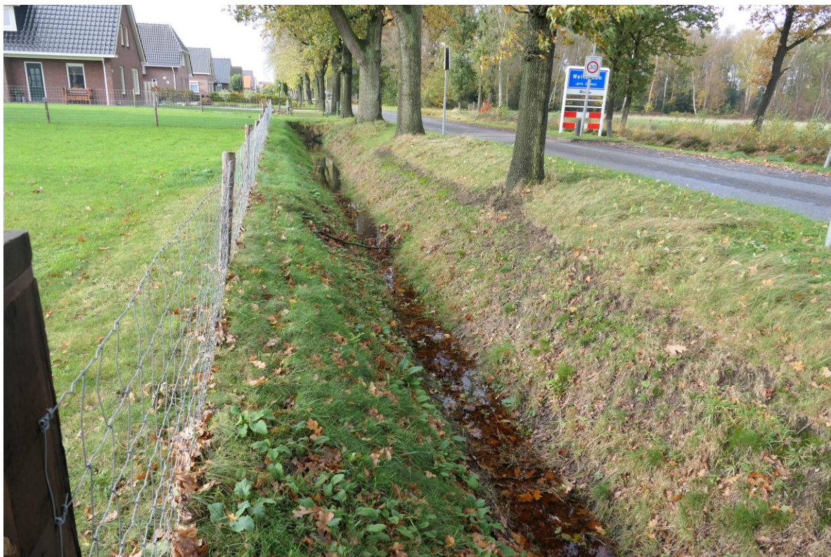
Figuur 1.4 Greppel aan de noordzijde van het plangebied.
