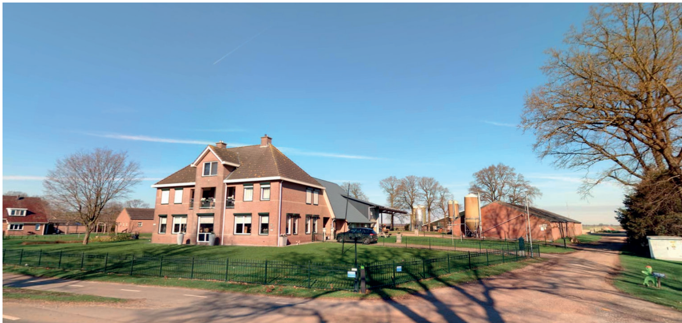
bestaande bedrijfswoning met daarachter de te slopen stallen
