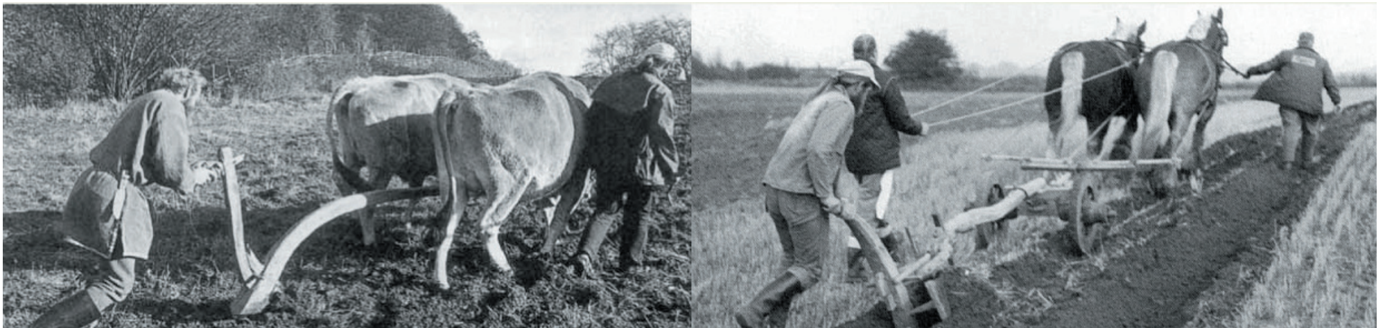
Afb. 11 Het eergetouw (links) en de keerploeg (rechts). Bron: Emmen in het perspectief van de es, Gemeente Emmen
