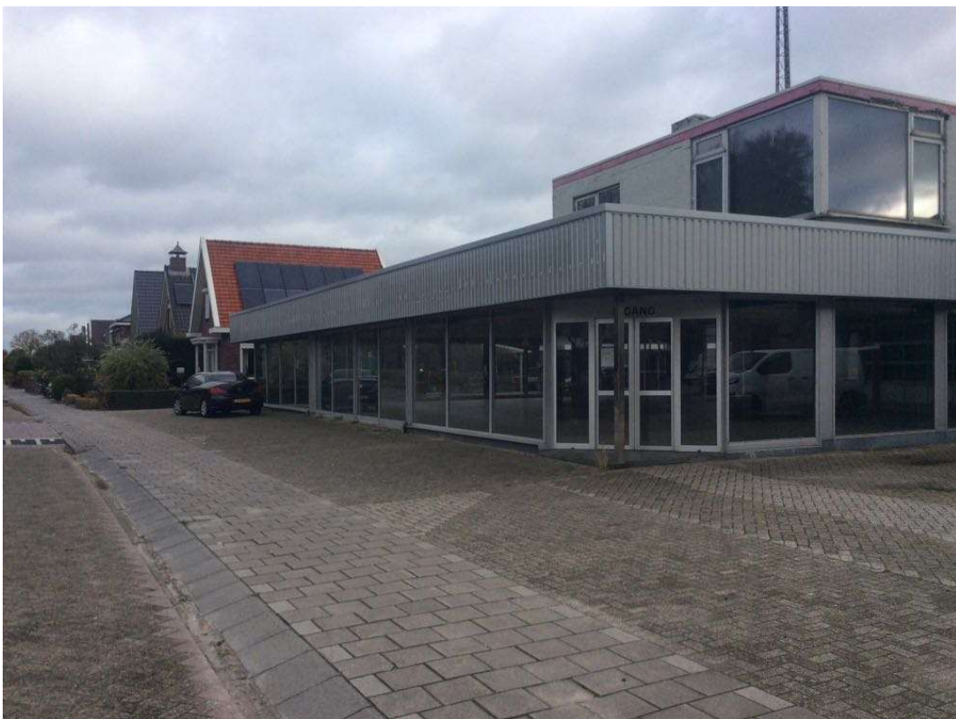
Vooraanzicht Brugstraat 153 in noordelijke richting (A4)
