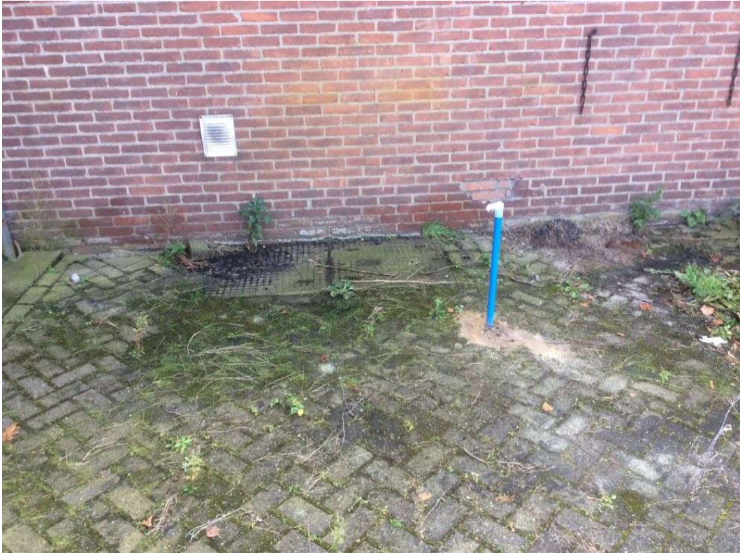
Olie/waterafscheider van wasplaats noordoostzijde nr. 153 (A3)
