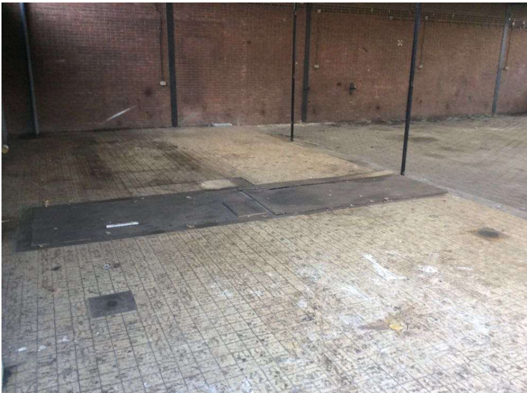
Noordelijk deel werkplaats oostzijde nr. 153 (A1) in oostelijke richting
