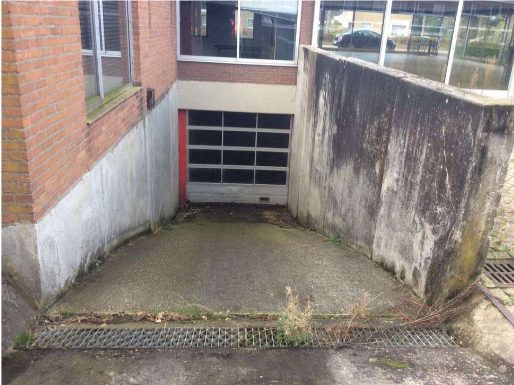
Ingang kelder onder showroom nr. 153.
