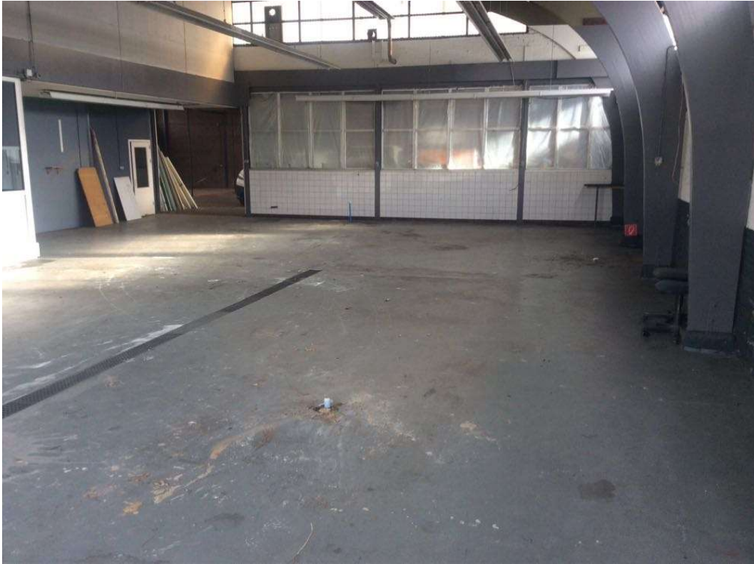
Werkplaats met betonverharding, zuidwestzijde nr. 153, in oostelijke richting (A4)
