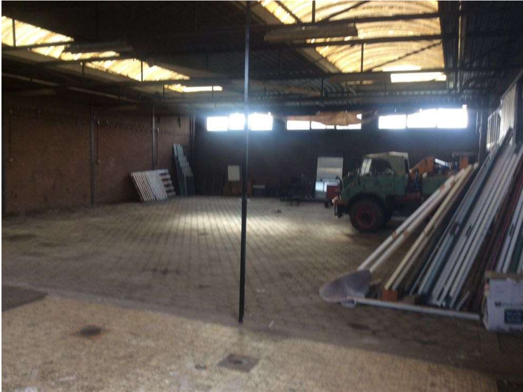
Werkplaats oostzijde nr. 153 (A1) in zuidelijke richting, ondergrondse tank (A2) onder voertuig rechts
