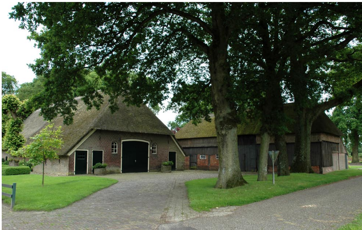
Historische monumentale boerderij met bijgebouw. Het totale erfensemble heeft de veldnaam 'Hof'.
