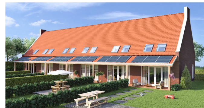
Voorbeeld van zonnepanelen in veranda zone waarbij het dakvlak van de veranda dient als energieopwekker
