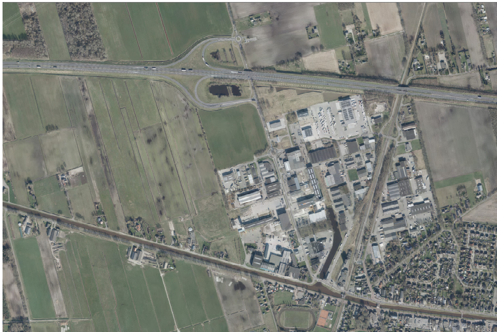
Afbeelding 1. Luchtfoto bedrijventerrein de Tweeling
