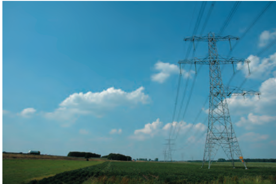
Afb. 5 Nieuwe infrastructuur in beekdal Sleenerstroom
