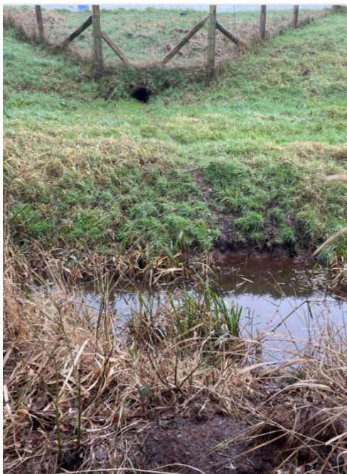
Afb.25 Wissel vanuit de sloot naar de tunnel onder de A37.
