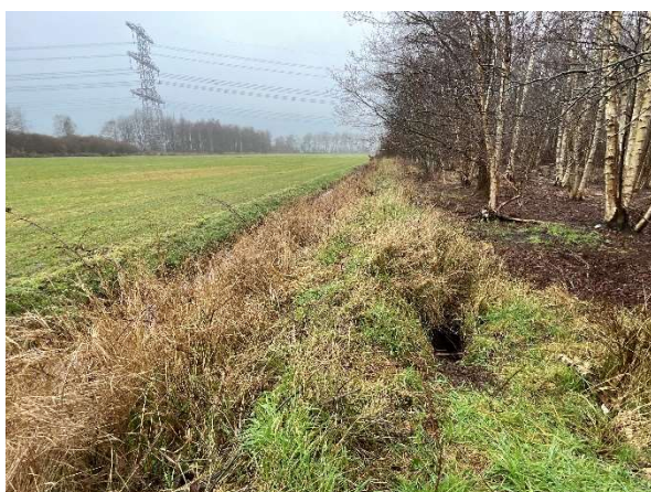
Afb.26 Een van de twee onbelopen pijpen in de dijk, ca 50 meter ten zuiden van de pijpen van de hoofburcht
