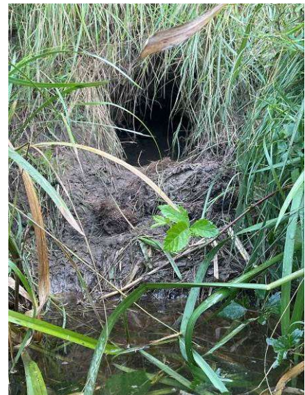
Afb.8 Een van de pijpen in het talud van de sloot, net boven de waterlijn
