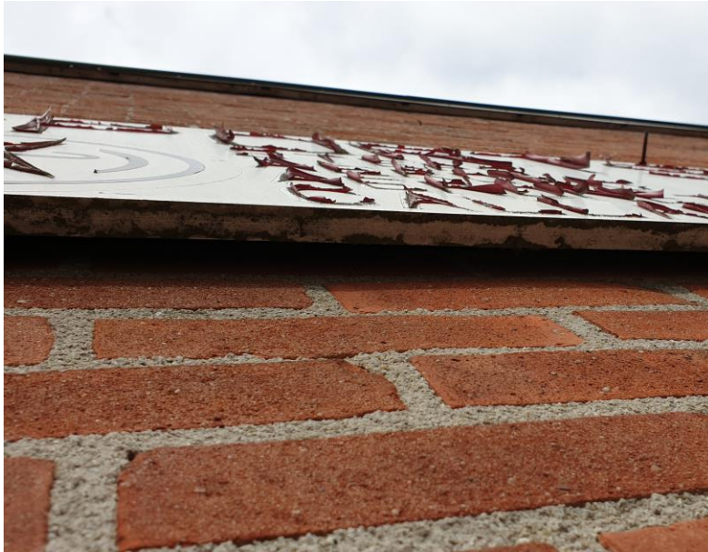
Figuur 4.3. Aanwezige ruimte tussen gevel en boeiboord.
