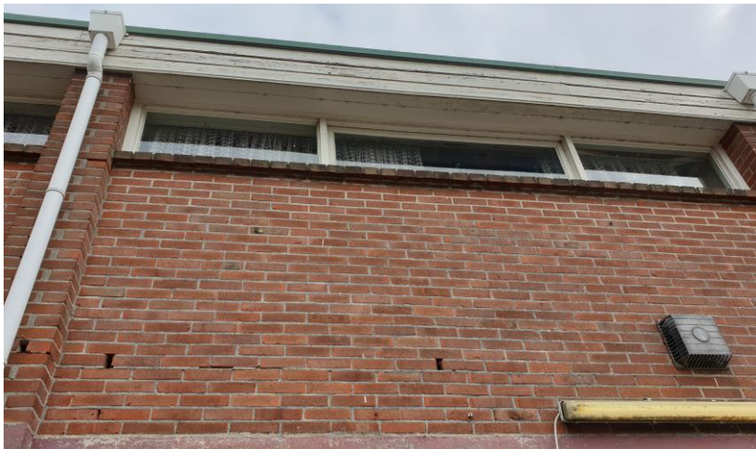
Figuur 4.2. Aanwezige open stootvoegen in het gebouw binnen het plangebied.
