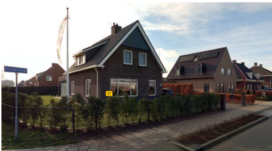
2 voorbeelden hoekwoningen in directe omgeving plangebied: twee-zijdige oriëntatie, geen bijgebouwen en haag als erfgrens
