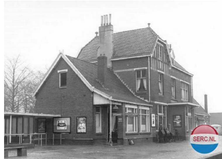
Het stationsgebouw uit 1905 (bron: www.fotos.serc.nl ).
