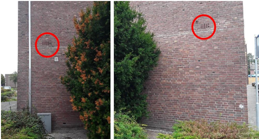
Foto 1 Ventilatieroosters in de zuidgevel van de Meridiaan 4 t/m 48.
