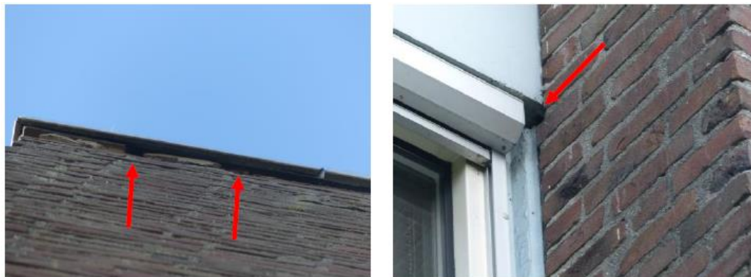
Foto 2 Geschikt invlieglocaties voor vleermuizen bij de dakrand en bij gaten in kozijnen in de Meridaanflat 64 t/m 98.
