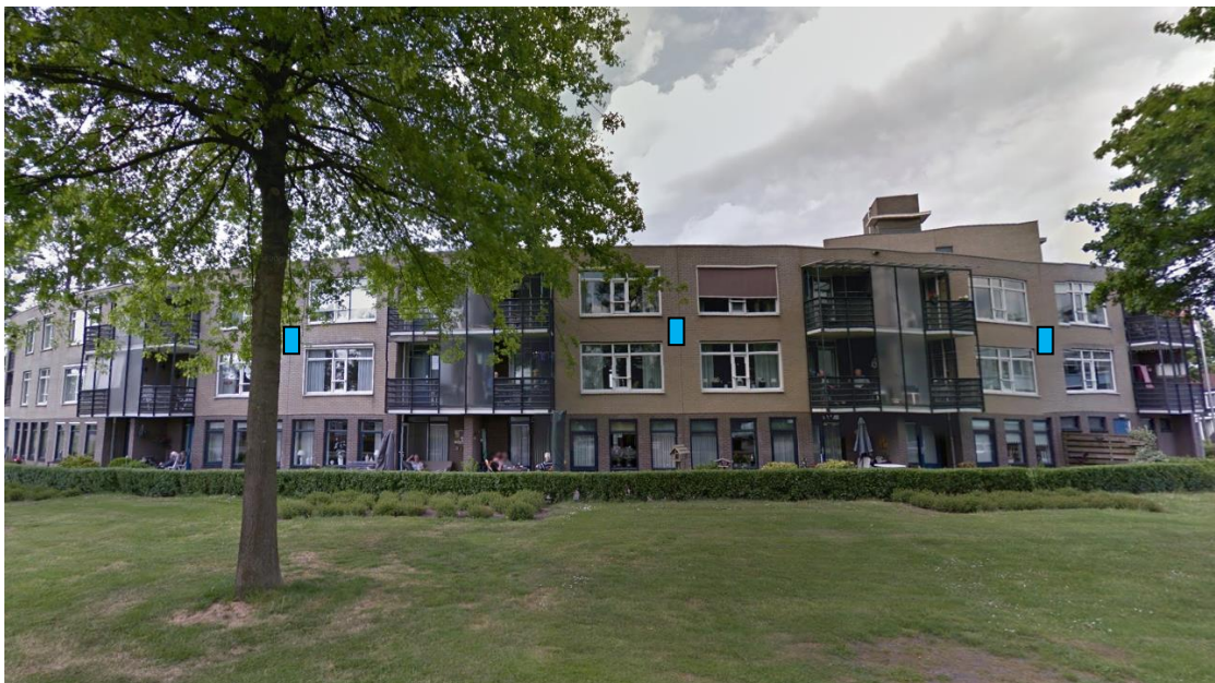
Foto 4 Voorbeelden van het ophangen van vleermuiskasten (aangegeven met blauw) met linksboven: vleermuiskasten aan de kopgevels van een rijtjeswoning aan de Sterrebaan en rechtsboven: het noordelijke deel van het gebouw de Zuiderkroon aan de Meridiaan. Onder: het zuidelijke deel van de Zuiderkroon.
