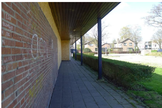
Foto 4 Brede overkapping maakt de opening tussen aftimmering en muur ongeschikt als invliegopening.
