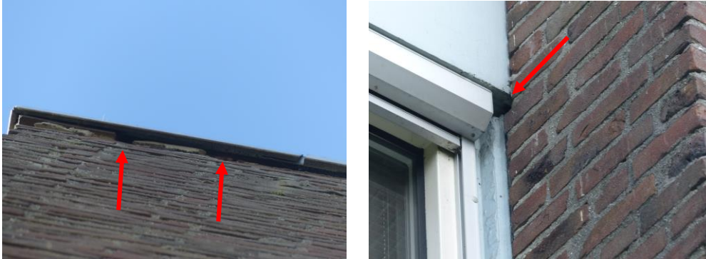
Foto 8 Geschikte invlieglocaties voor vleermuizen bij het flatgebouw aan de Meridiaan, bij de dakrand (links) en bij kozijnen (rechts).
