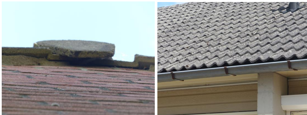
Foto 2 De kopgevels van de woningen aan De Kap zijn dicht en dus ongeschikt voor gierzwaluwen (links). De daken van deze woningen zijn wel geschikt voor de huismus (rechts).
