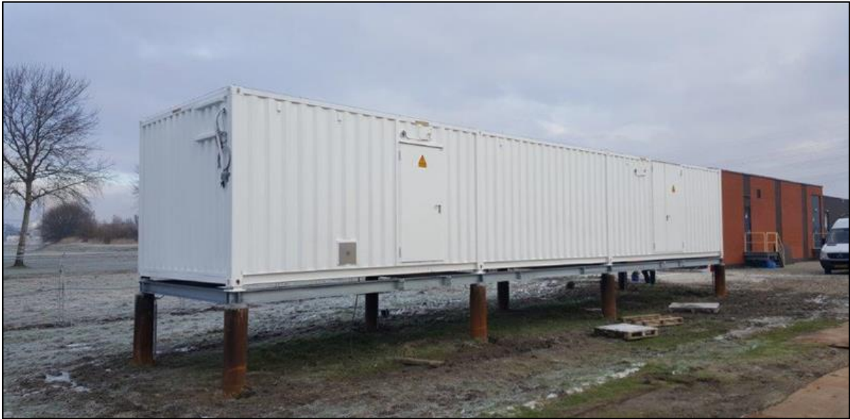
Afb. 2. E-house op fundatiepalen
