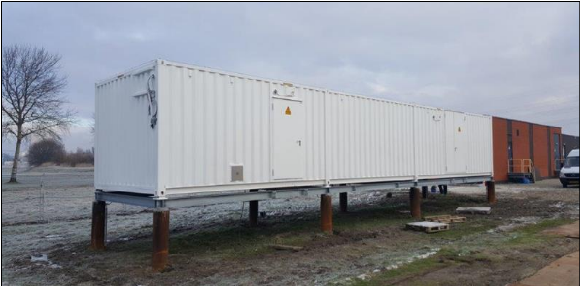
Afb. 2. E-house op fundatiepalen
