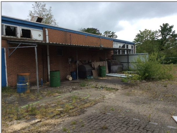
Foto 3: Deellocatie C bovengrondse en ondergrondse tank
