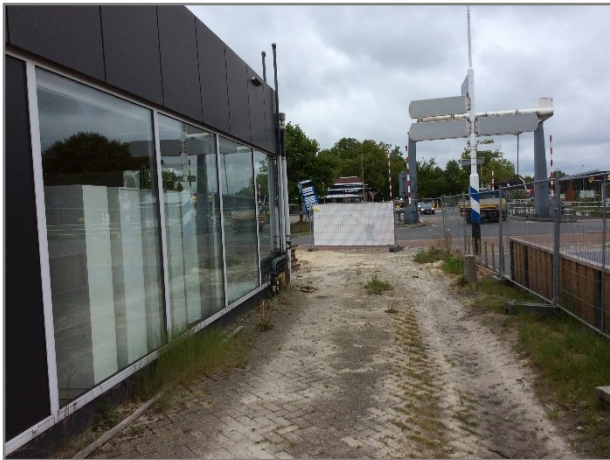
Foto 7: Deellocatie F westzijde / ontluchtingspunt
