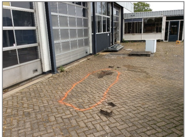
Foto 4: Deellocatie D ondergrondse tank
