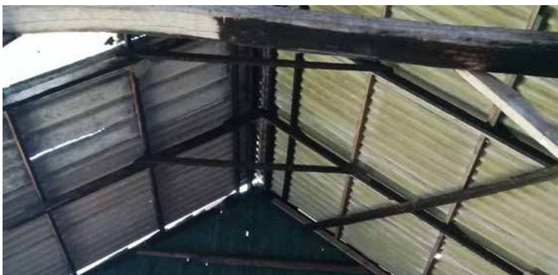
Dak van de kapschuur van de binnenzijde.
