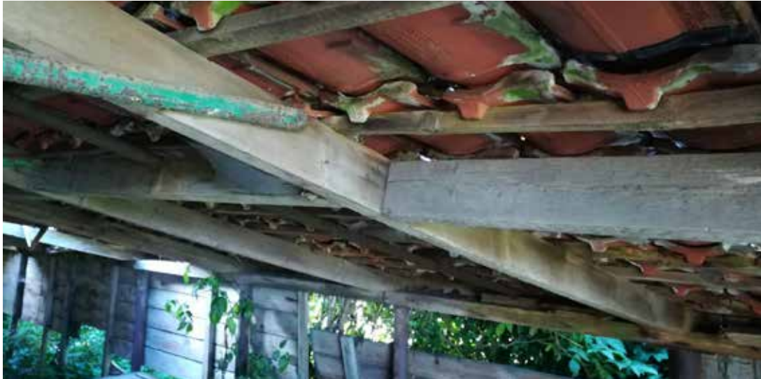
Pannendak zonder dakbeschot, dak aanbouw kapschuur.
