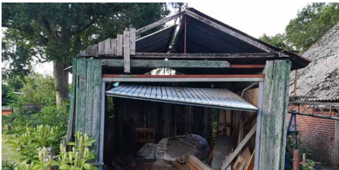
Kleine schuur achter de kapschuur.
