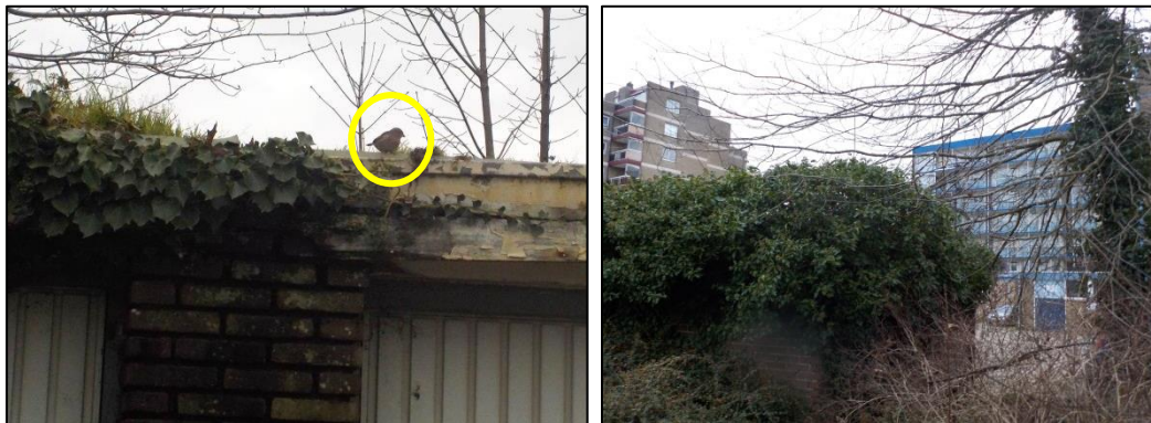
Figuur 4 Huismusvrouwtje op het dak van de garagebox blok nr. 2. met de klimop waar de drie huismussen foeragerend en rustend waargenomen zijn.
