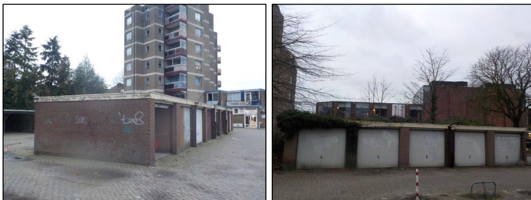
Figuur 2 Impressie van de te slopen garageboxen, blok 1 en blok 2.
