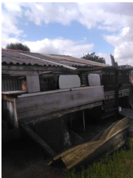
Foto 2: asbestverdacht dak
