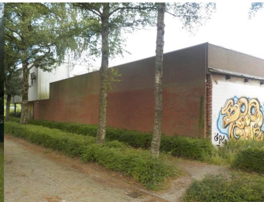
Foto 4 Het lagere deel van het te slopen gebouw
