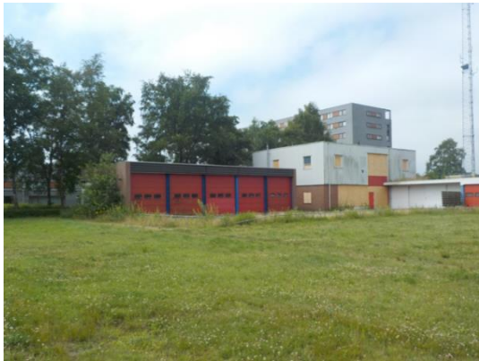
Foto 1 Impressie van het te slopen gebouw
