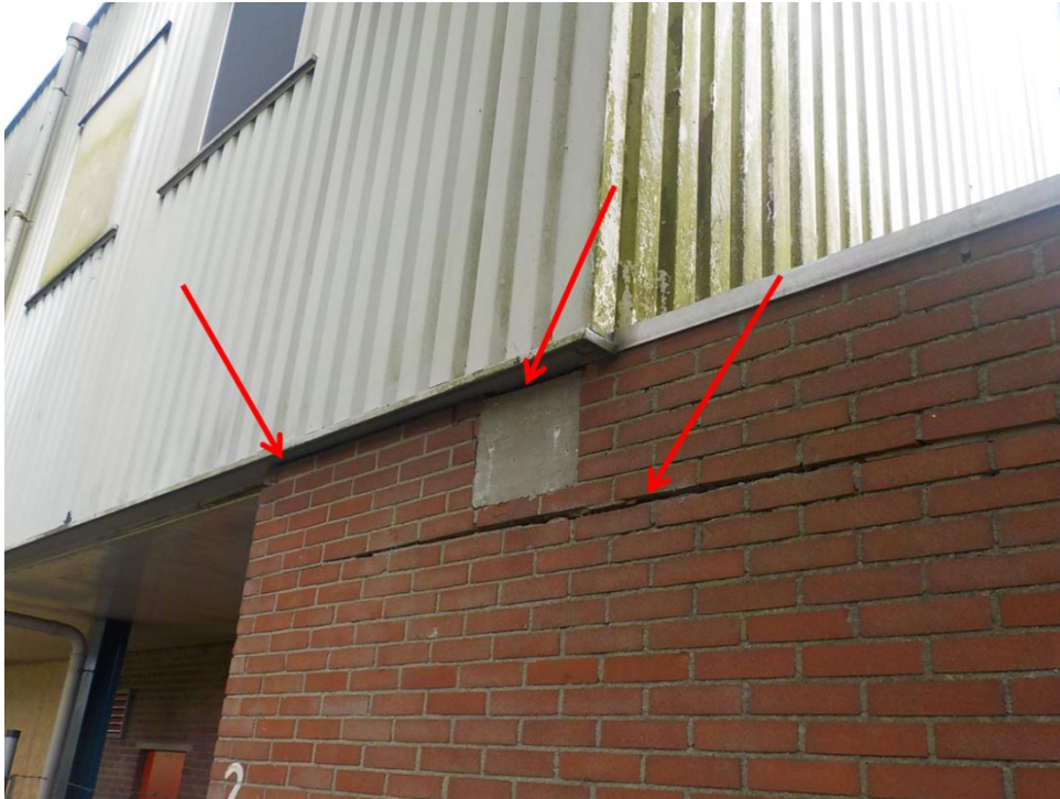
Foto 12 Voorbeelden van kieren die vleermuizen als (toegang tot) verblijf kunnen gebruiken.
