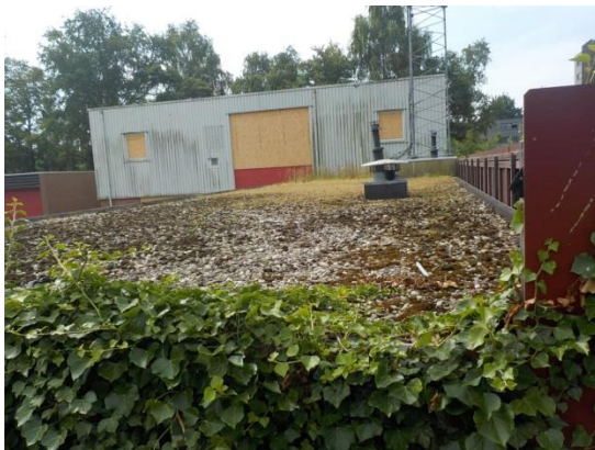
Foto 5 Plat dak van het te slopen gebouw
