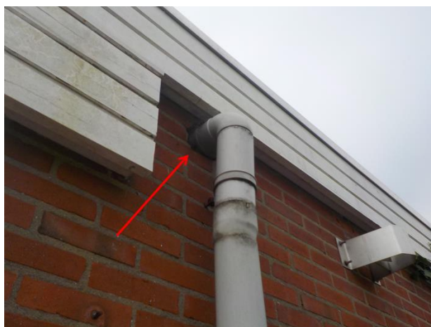
Foto 15 Voorbeeld van kieren die vleermuizen toegang kunnen bieden tot de spouw.
