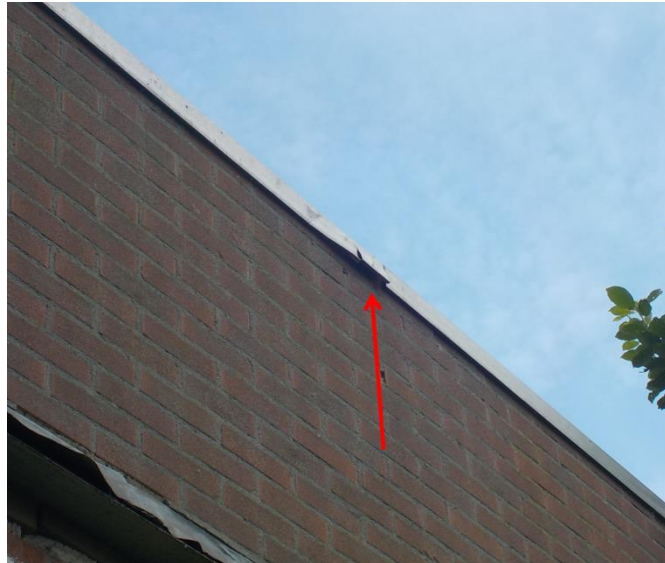
Foto 14 Voorbeeld van kieren die vleermuizen toegang kunnen bieden tot de spouw.
