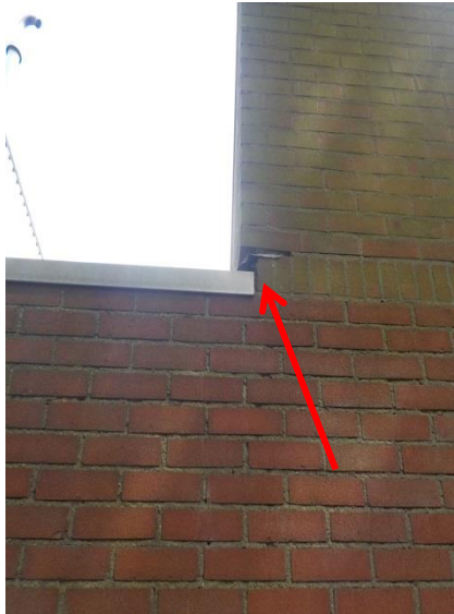
Foto 13 Voorbeeld van kieren die vleermuizen als toegang tot verblijf kunnen gebruiken.
