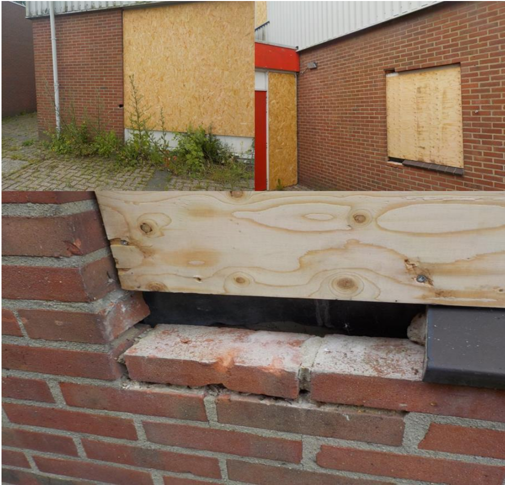
Foto 16 Boven: openingen in de muur die toegang bieden voor steenmarter; onder: detail uit de foto rechtsboven.
