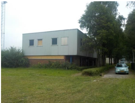
Foto 3 Het hogere deel van het te slopen gebouw
