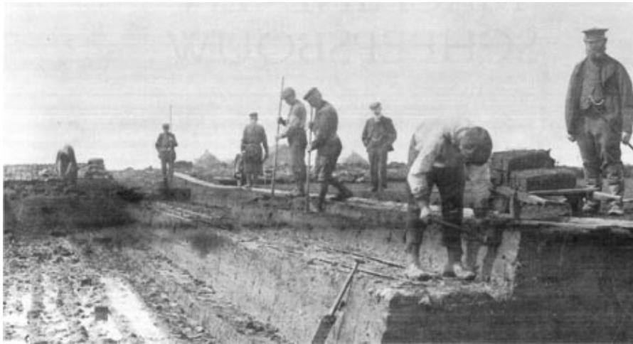
Afb. 4.2 Links: Met een speciale schop, stikker genoemd, werden laagsgewijs sneden ter grootte van een turf gemaakt.
