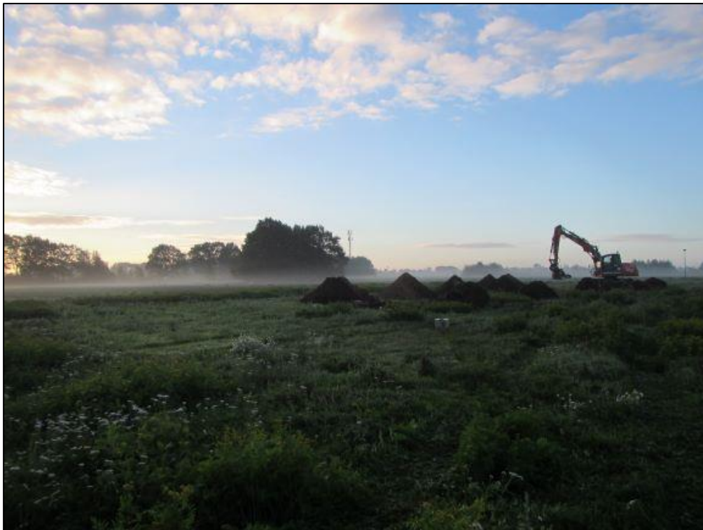
Afbeelding 3. Aanleg van werkput 4 in deellocatie 6.4
