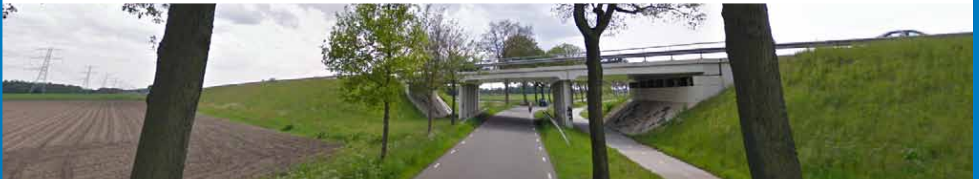
Bestaande viaduct Brinkmade bij Sleen (bron: Google maps)
