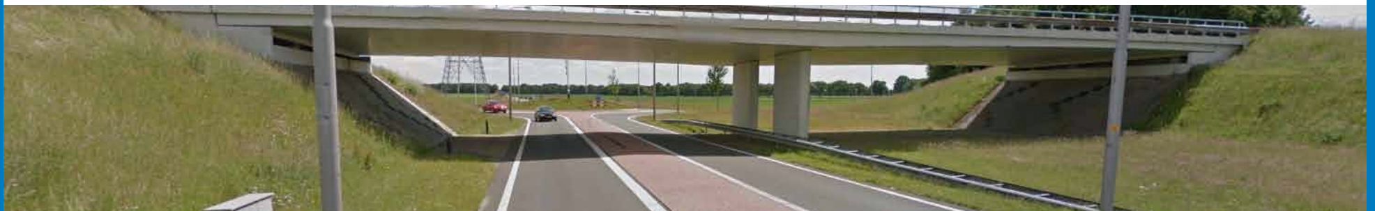
Bestaande viaduct Staphaarst bij aansluiting N381 (bron: Google maps)
