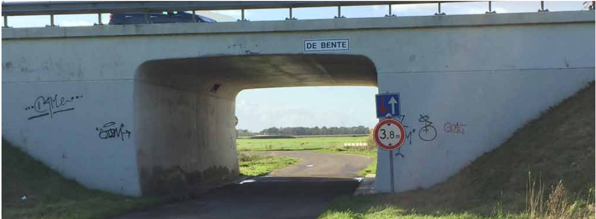
Bestaande onderdoorgang De Bente - Benterdijk bij Dalen
