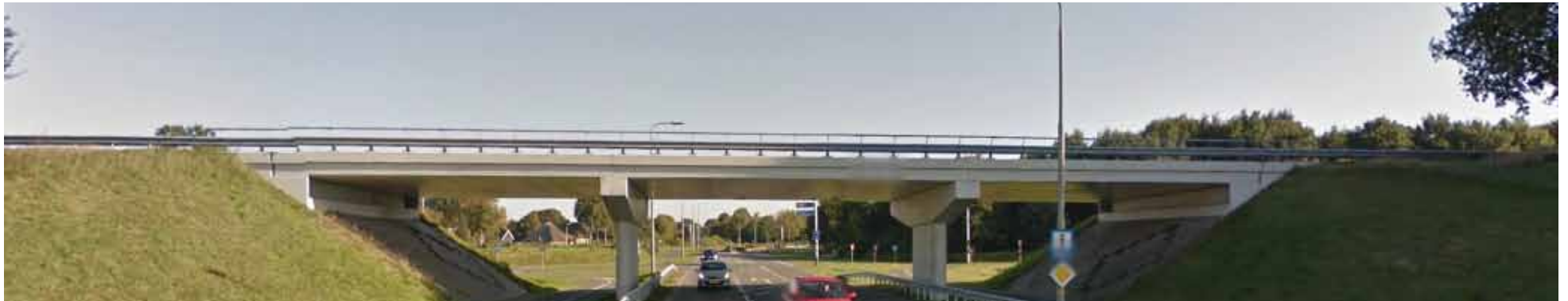
Bestaande viaduct Valsteeg bij Dalen (bron: Google maps)
