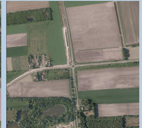
Ombouw aansluiting Emmerweg
