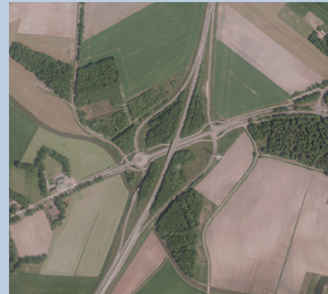
Ombouw knooppunt N34-N391
