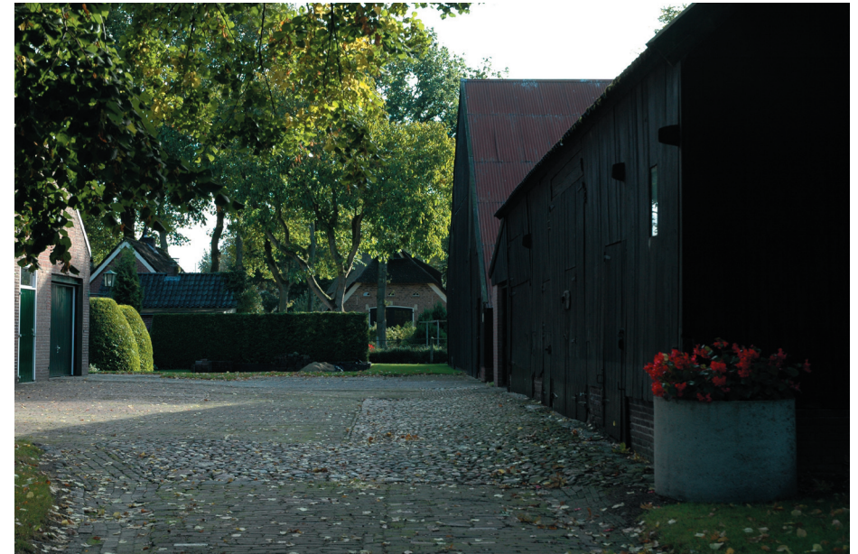
Karakteristieke bebouwingstructuur met verschillende nokrichtingen
