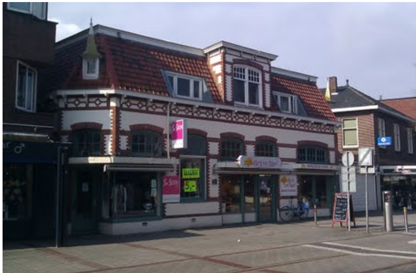
winkelpand 1910 (beeldbepalend bouwwerk)
