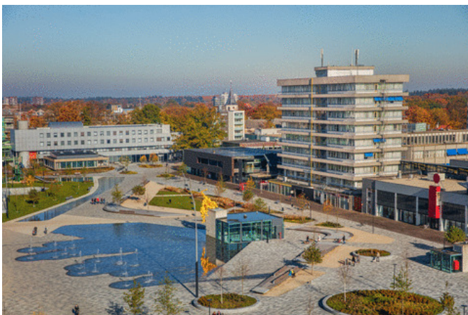
Beeldbepalende bouwwerken aan het plein (Kantoor Belastingdienst en Gemeentehuis)
