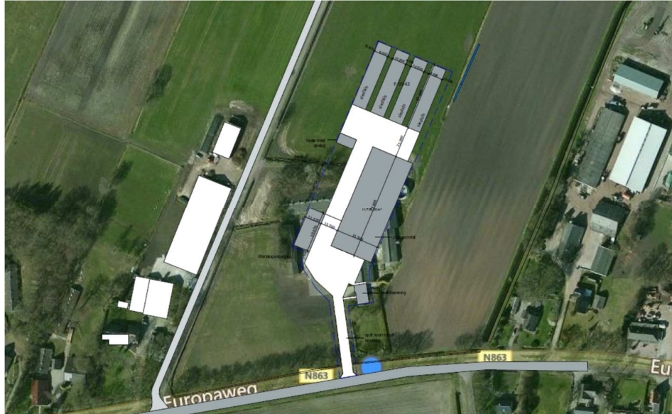
• Afbeelding 1 Luchtfoto projectlocatie
