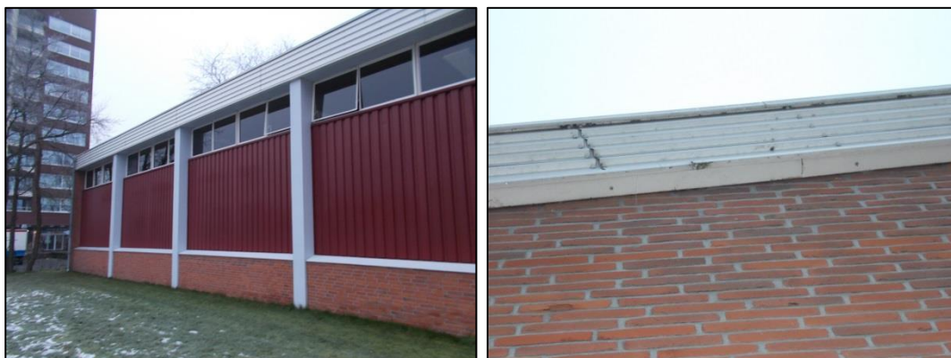
Foto 2 Invliegopeningen voor vleermuizen zijn afwezig, de daklijst is strak afgewerkt tegen de gevel. Open stootvoegen en kieren ontbreken.
