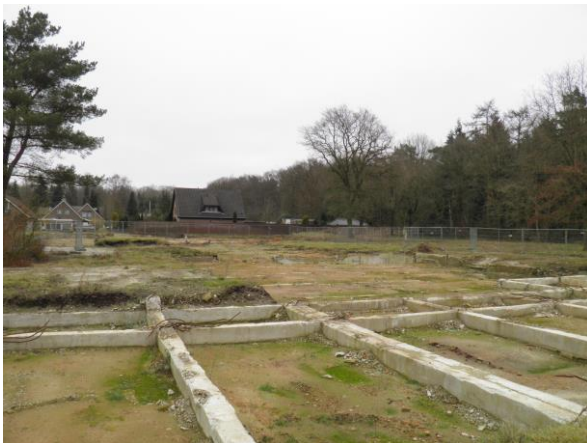
Figuur 2. Overzicht van de locatie Hagedoorn vanuit zuidelijke richting.
