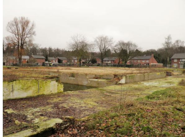
Figuur 5. In een lager deel van het terrein aan de Sleedoorn is tussen de funderingen een plas ontstaan.
