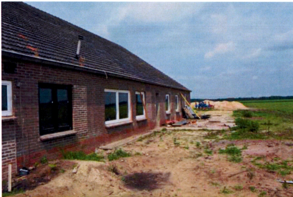
Foto 1. Een deel van de bestaande gebouwen.
