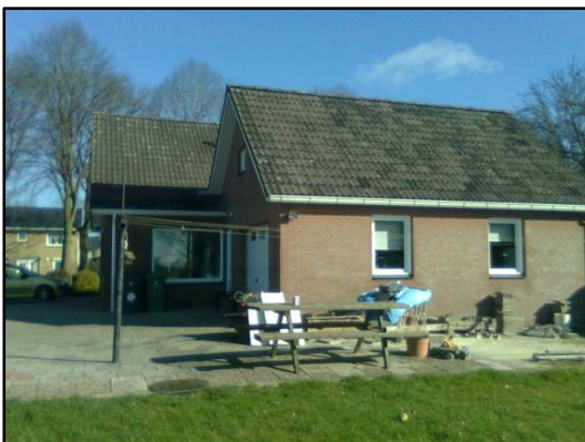
Achtergevel en aangebouwde garage
