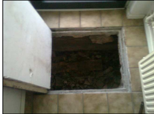
Toegang tot de kruipruimte
