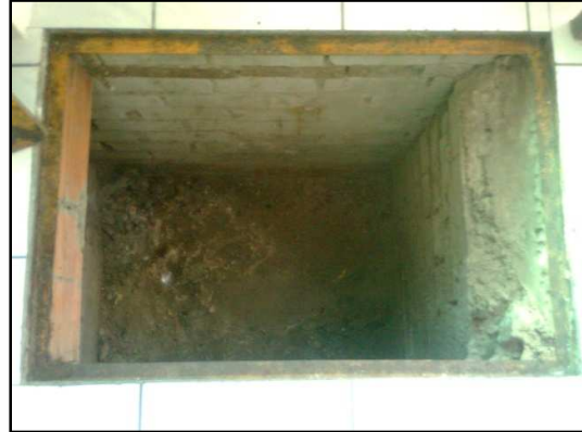
Toegang tot de kruipruimte
