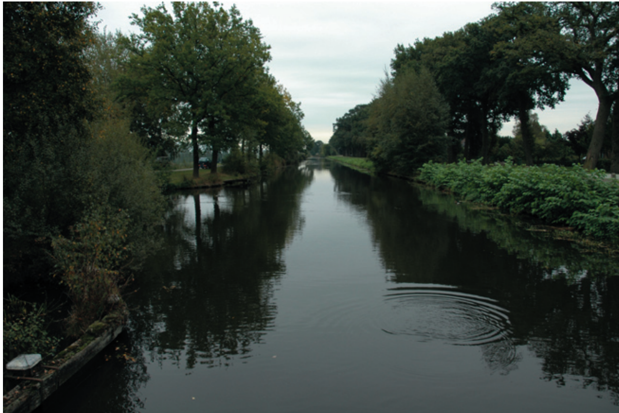
Dommerskanaal deels verscholen achter struweelbeplanting; hier bij kruising Dommerskanaal ZZ en Beekweg
