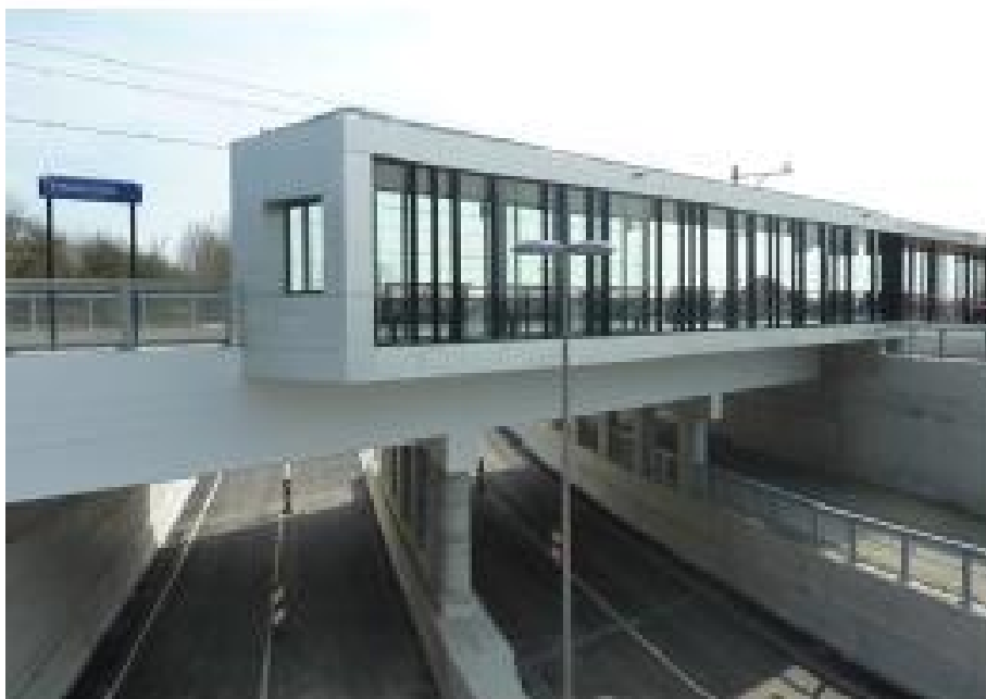
Fig. 3: perron met wachtruimte geïntegreerd met onderdoorgang (foto Grontmij)
