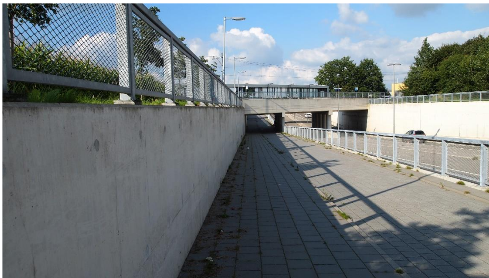
Fig. 5: ontsluiting tweede perron via onderdoorgang. Langzaam verkeer is gescheiden ten opzichte van snel verkeer. Het halen en brengen geschiedt aan de huidige zijde.
