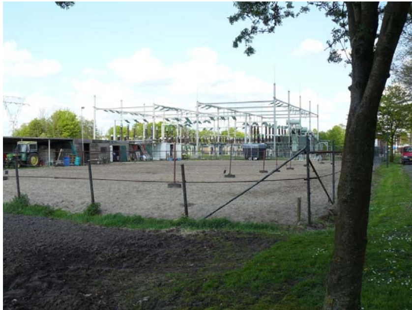
Foto 1: huidige paardenbak ten westen van trafostation
