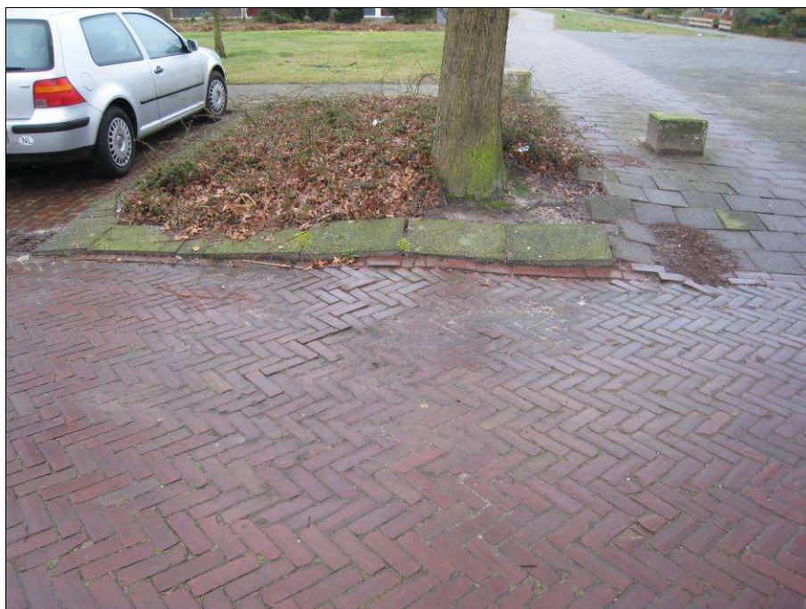
Openbare ruimte is toe aan renovatie
